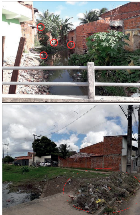
Figura 10 – Coletânea de imagens referentes as problemáticas encontradas na BHRM
