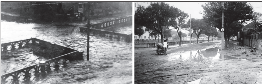
Figura 2 – À esquerda: transbordamento do córrego do Leitão, 1940. À direita: Avenida do Contorno após o transbordamento do ribeirão Arrudas, década de 1970
