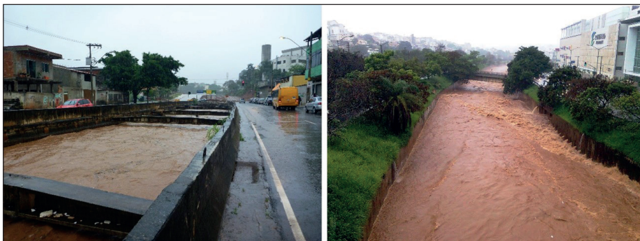
Figura 5 – O ribeirão Arrudas em dois momentos: à esquerda pouco antes do seu transbordamento em novembro de 2011, à direita o grande canal conduzindo as águas pluviais à jusante da zona urbana planejada
